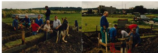
På Toldbodgade graves der til fundament
